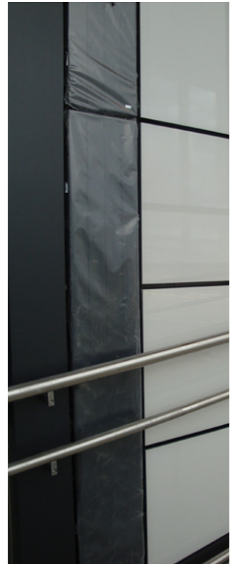
BEMM Pawa V (Abb. rechts noch mit serienmäßiger Schutzfolie als Bautenschutz). Gut zu sehen ist, dass die Fugen zwischen den Wandpaneelen in gleicher Breite zwischen Paneelen und Heizkörpern sowie Heizkörpern und Wand verwirklicht wurden. Des Weiteren ist gut zu erkennen, dass die Front der Paneelheizwände völlig plan fluchtet mit den Wandpaneelen und der Mauerwand. Außerdem ist zu sehen, dass die Gesamthöhe von 5 m durch mehrere übereinander montierte Heizkörper erreicht wurde.
