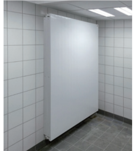
BEMM Pawa V, 2-reihig ohne Lamellen, 1800 x 1260 mm, integriertes Ventil oben, galvanisch verzinkte Sonderausführung für erhöhte Anforderungen in Sanitärräumen, Einbausituation in der BayArena.
