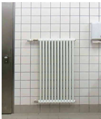
BEMM Mera, galvanisch verzinkt , anschließend pulverbeschichtet weiß 9016, für Feuchträume geeignet, JVA Bremervörde, Einbausituation in der Küche, vandalensichere Befestigung.
