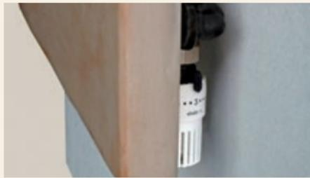
Zentralheizungsbetrieb - Thermostat und Anschlüsse werden vom unteren Teil des Heizkörpers verdeckt
