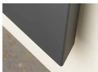
Feine Seitenlinie mit 60° Winkel und Schattenfuge.
