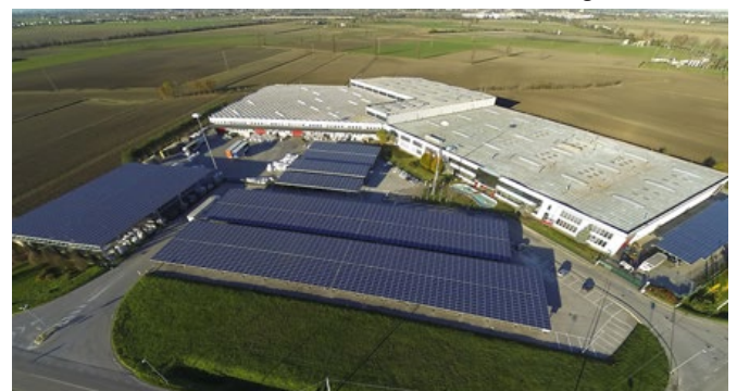
Produktionsstätte mit Blick auf die Photovoltaikanlage
