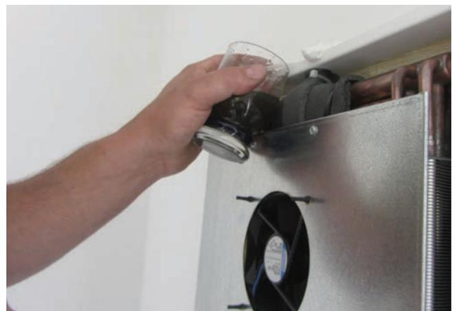
5.18 - Nach Befüllen, am Geräteteil oben entlüften.
