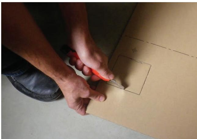
5.5 - Schneiden Sie den Bereich für die späteren Anschluss-
