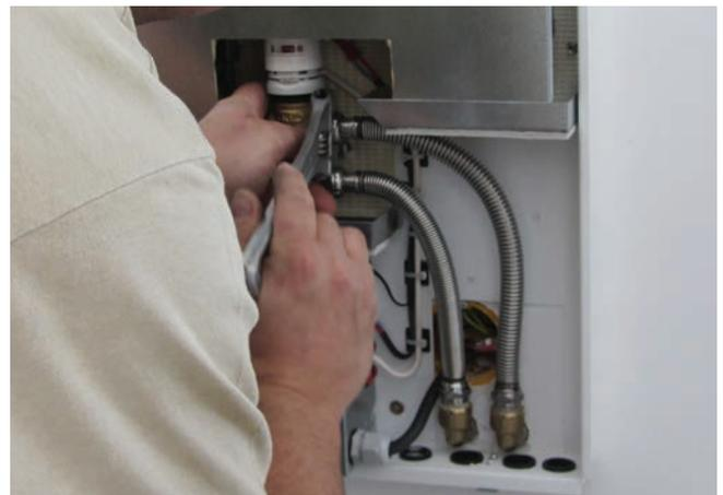
5.16 - Alle Verschraubungen festziehen und korrekten Sitz kontrollieren.
