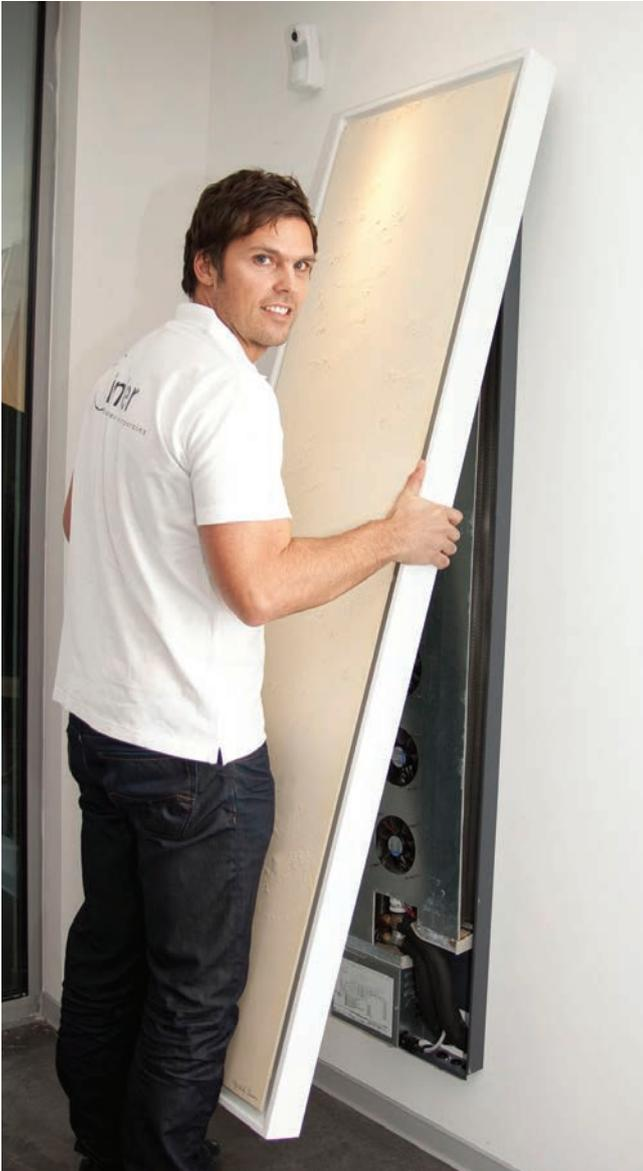
5.19 - Rahmen mit Motiv-Frontplatte oben einhängen und danach unten mit den beiden Verschlüssen verriegeln.
