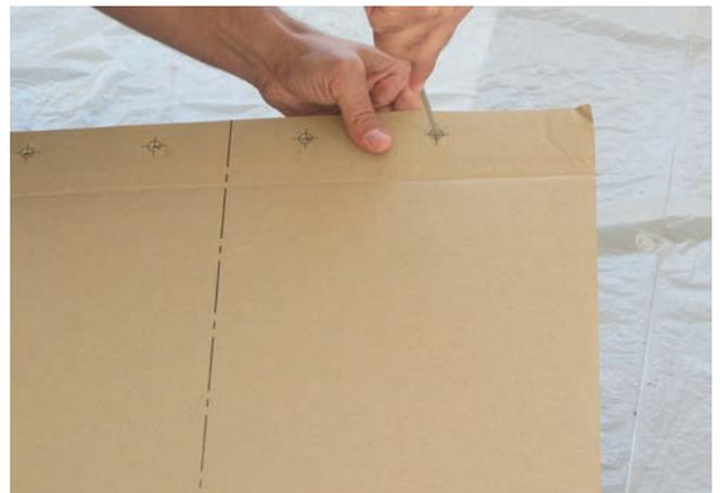
5.4 - Bohren Sie die Löcher oben in der Schablone.
