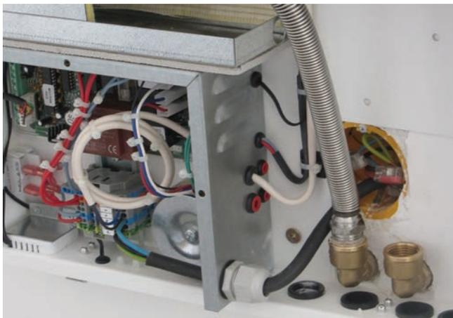
5.15 - Wasserverbindungen mit den flexiblen Anschlussrohren herstellen.
