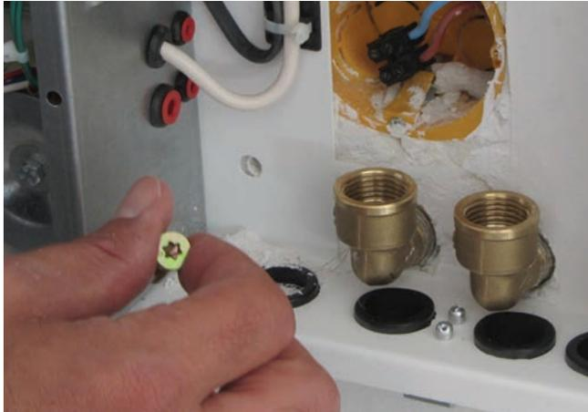
5.13 - Geräteteil unten gegen Abziehen mit der Wand verschrauben.
