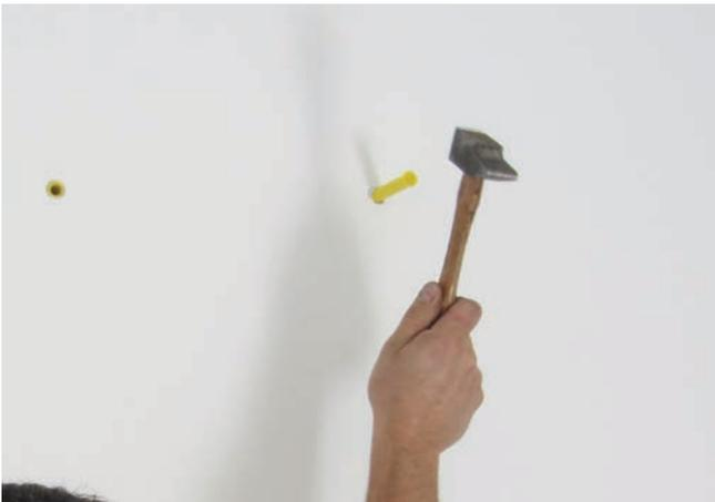
5.9 - Geeignete Dübel einsetzen.
