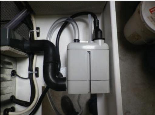
Anschlussbereich unten, mit Elektro-Anschlusskasten.
