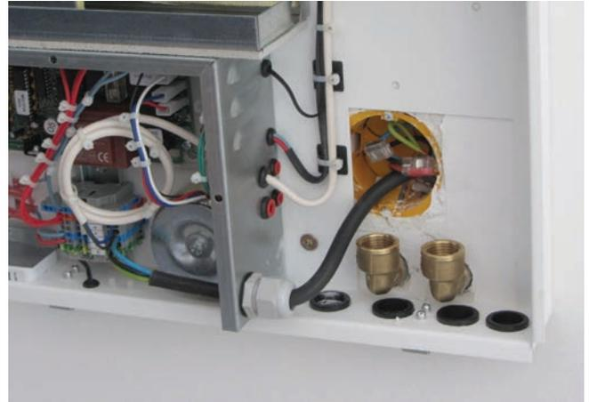
5.14 - Fertig hergestellter elektrischer Anschluss.
